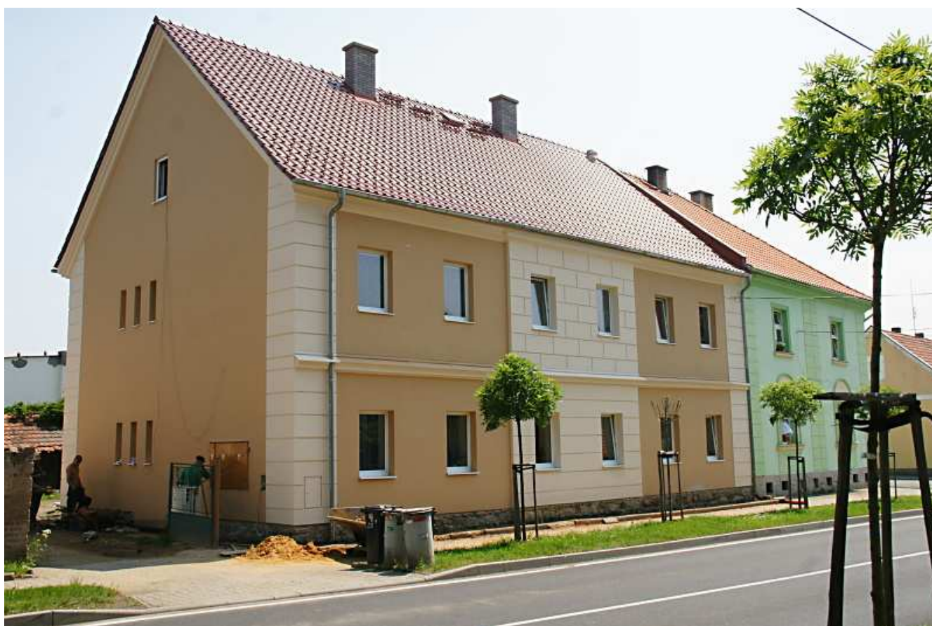
Opravený městský dům v Plzeňské ulici
