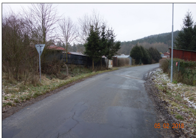
Silnice III/2295 do obce Drahouš
