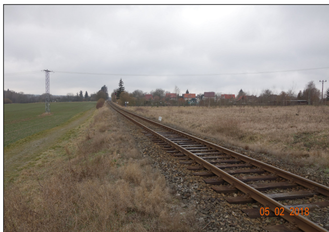
Železniční trať č. 161 - pohled k městu Jesenice
