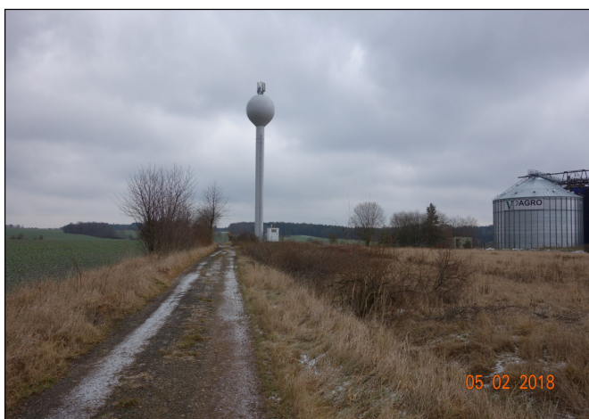
Stávající polní cesta v místě křížení se silnicí (varianta 1) a vodojem
