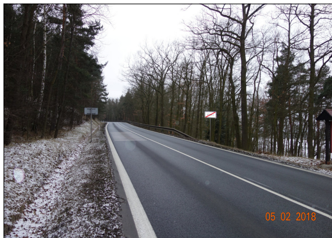
Silnice I/27 na konci stavby ve směru na Plzeň
