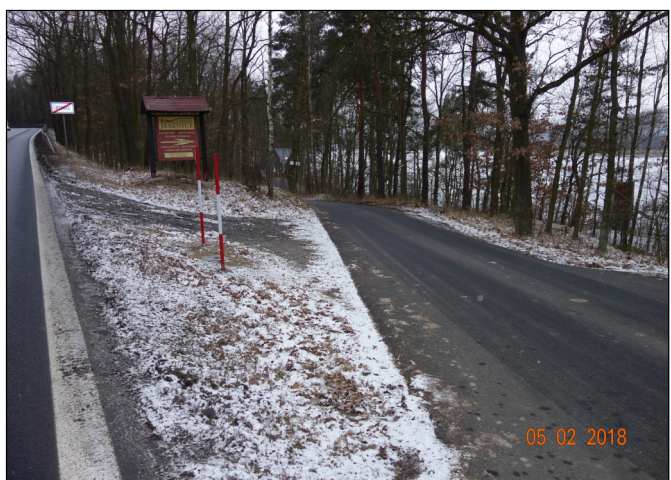
Sjezd na účelovou komunikaci k chatám a hotelu Jesenice
