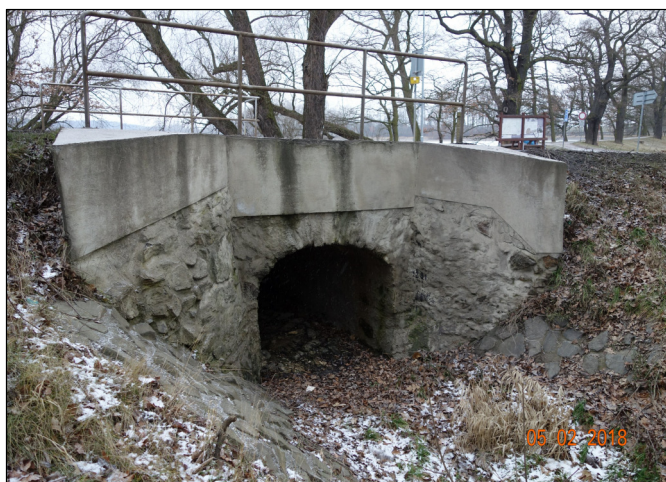
Stávající propustek pod silnicí I/27, který bude využit v rámci stavby
