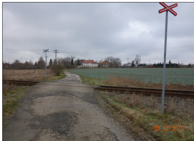
Železniční přejezd na účelové komunikaci v místě křížení se sil. I/27
