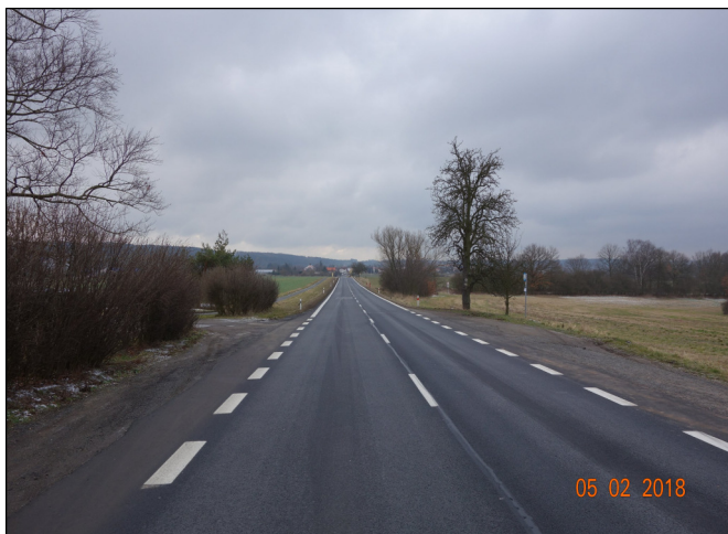
Stávající silnice I/27 na začátku stavby od hřbitova k Jesenicí
