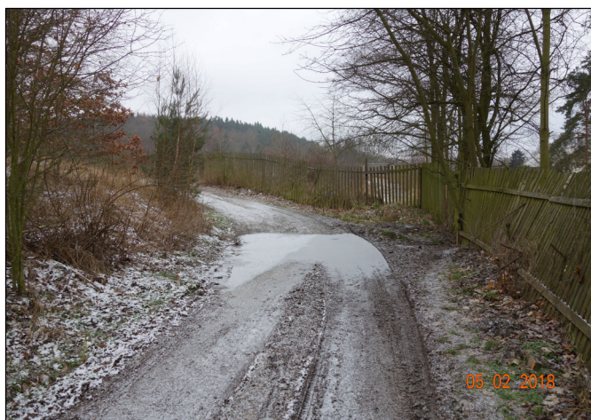
Stávající účelová komunikace za pilou - oprava v rámci stavby
